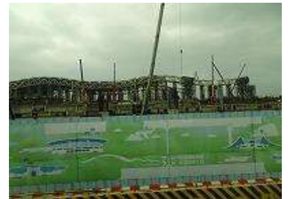
空港第3ターミナルビルの建設が進められていました。
