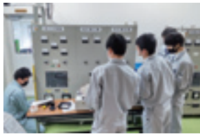
配電盤による実習
