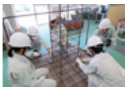
鉄筋組立て実習
