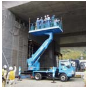
現場見学会 (静岡バイパス橋梁耐震補強工事現場)
